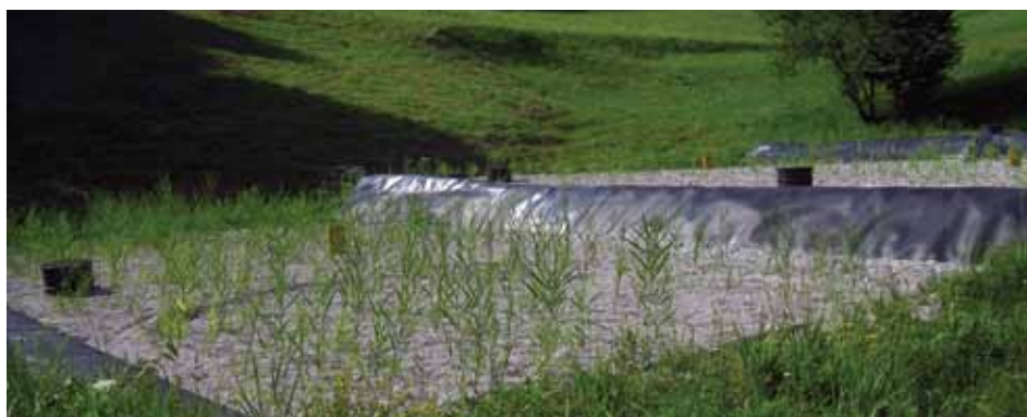
Biološka čistilna naprava v Dobju
