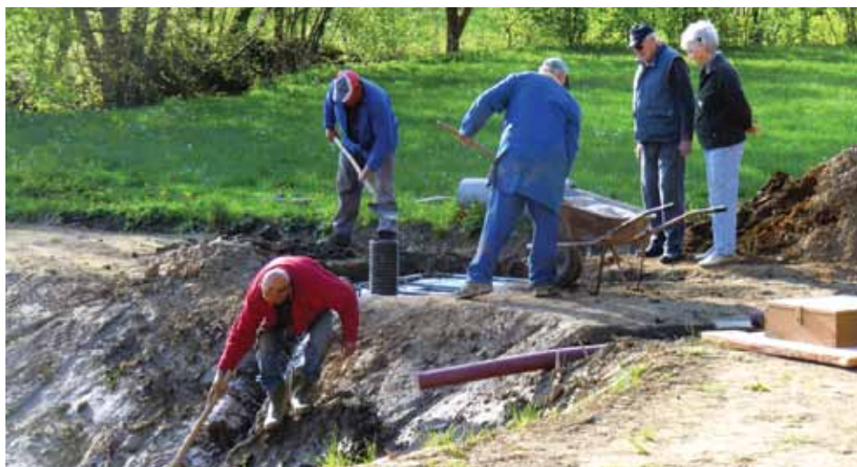
Urejanje okolice ob potoku Brezničica
