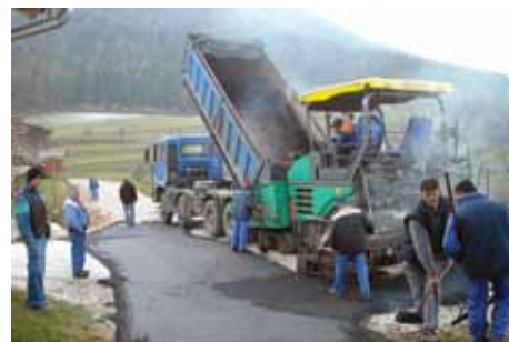
Asfaltiranje ceste v Breznu
